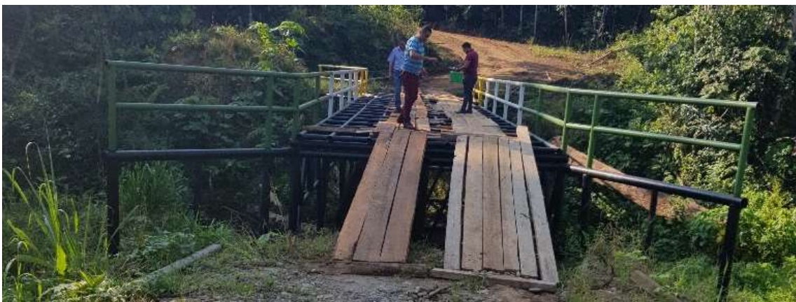
Fotografía N° 29. Puente Comunidad Tuncay 1.
