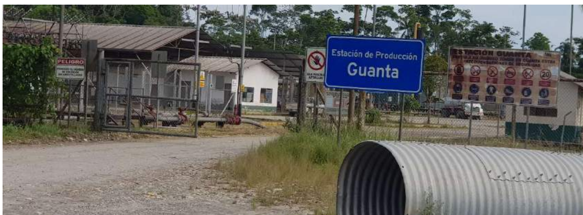
Fotografía N° 4. Estación de Producción Guanta.
