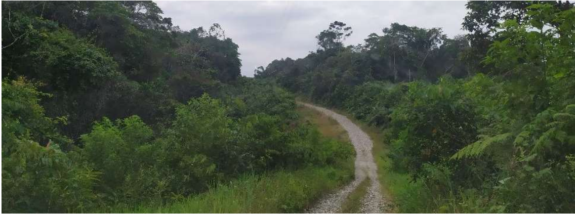
Fotografía N° 27. Estado de vía hacia comunidad La Lojanita.
